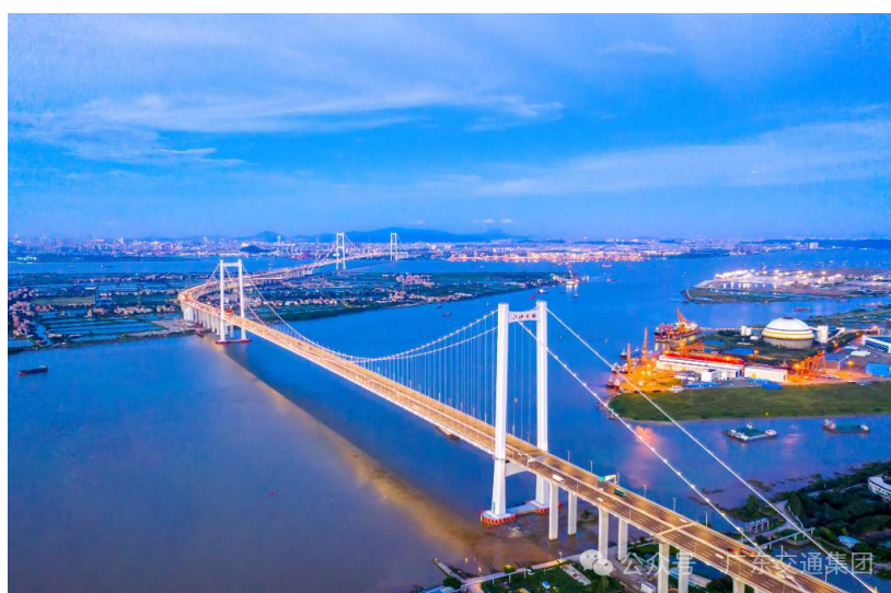
南沙大桥夜景
