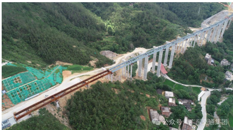
建设中的钢板组合桥梁
