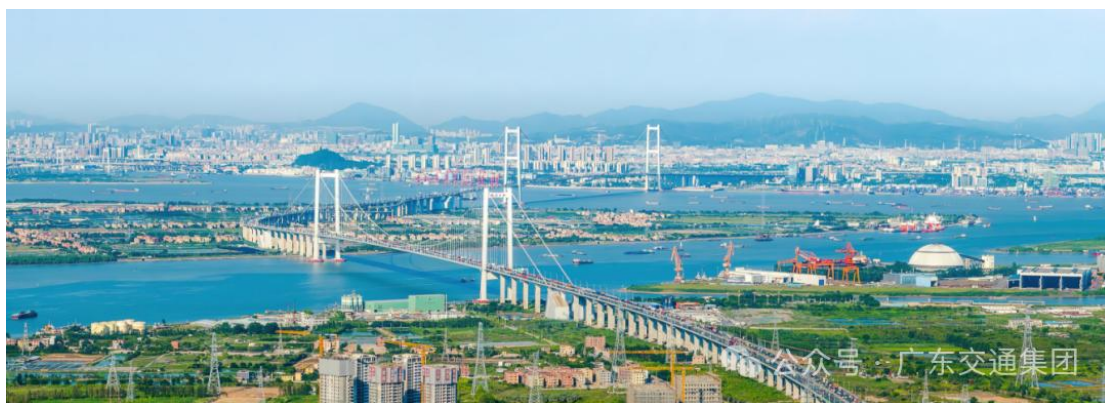
南沙大桥全景
