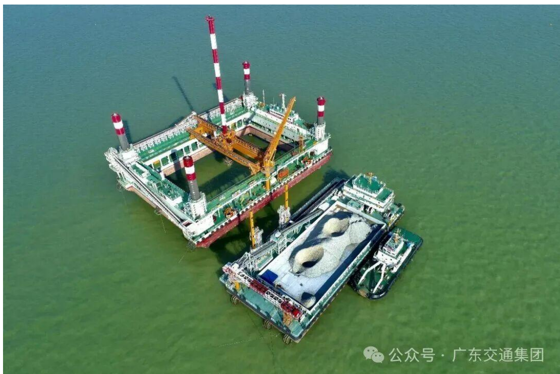
世界首艘自升式隧道基础碎石铺设整平船
