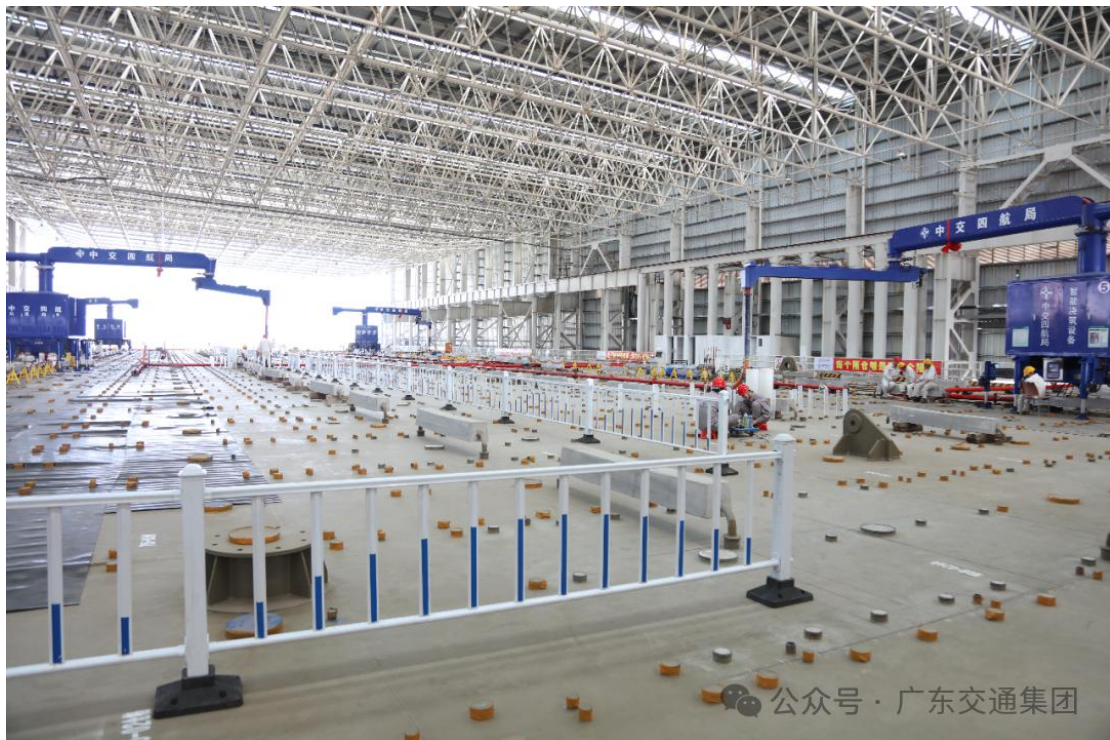
世界首制壳-混凝土沉管智能浇筑设备
