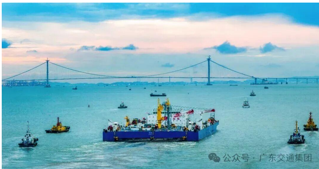
世界首制沉管管节浮运安装一体船
