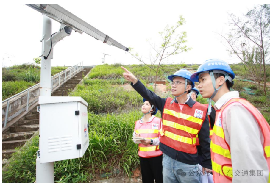
许肇峰（中）在边坡监测项目现场检查指导
