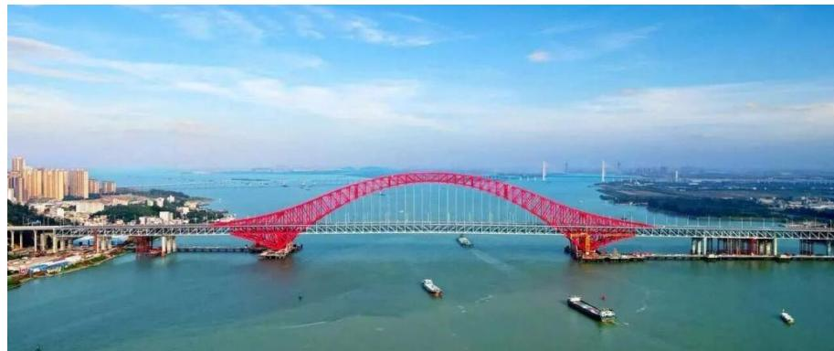
**富龙西江特大桥：**依托仿生学思路打造白鹭造型桥塔，形态轻盈灵动；同时率先应用 UHPC 高性能混凝土新材料，大幅提升工程品质与耐久性。桥体与西江两岸的旖旎风光浑然天成，尽显“桥景合一”的独特岭南韵味。
