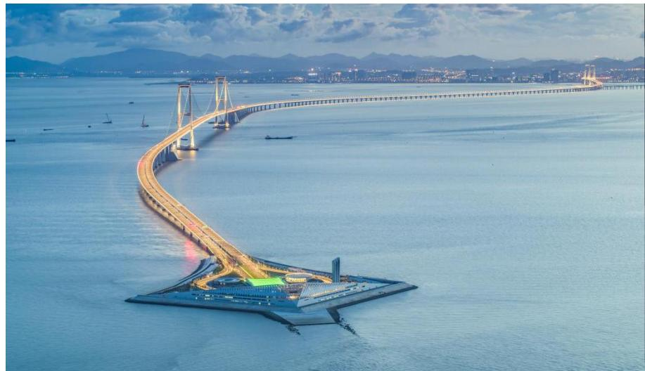
**黄茅海跨海通道：**创新采用“小蛮腰”渐变式桥塔设计，既有效降低风阻、提升结构稳定性，又赋予桥体灵动优雅的视觉观感。项目同步践行生态友好理念，施工阶段专项制定海洋生物保护方案，实现工程建设与海洋生态系统的和谐共生，完美诠释了工程之力与自然之美的平衡统一（同时获得最佳视觉艺术奖）；
