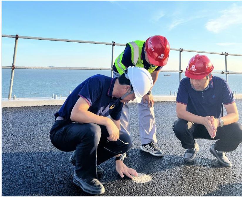
杨东来在施工现场
