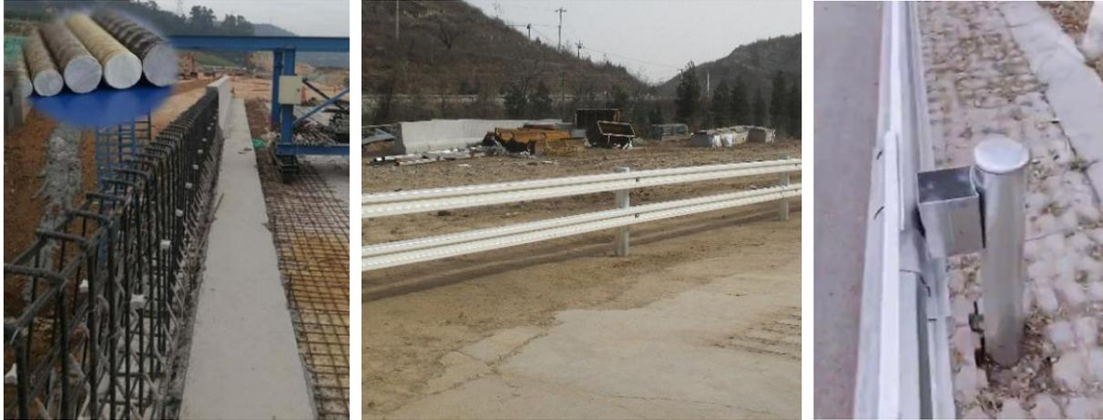
a) 玻璃纤维筋新型混凝土护栏
